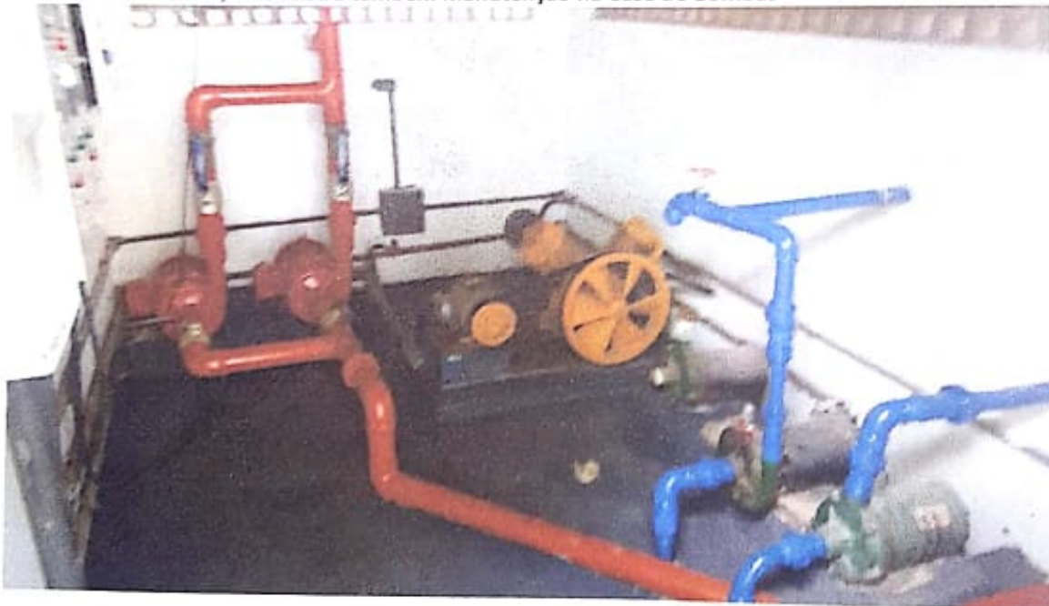
FOTO 4: Bombas já rebobinadas, com troca dos seus respectivos sêlos, eixos lubrificados e recolocados no local, demonstra também manutenção na Casa de Bombas
