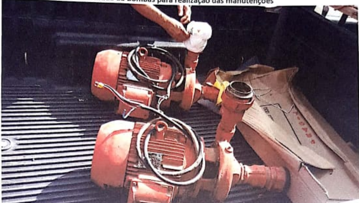
FOTO 4: Bombas já rebobinadas, com troca dos seus respectivos sêlos, eixos lubrificados e recolocados no local, demonstra também manutenção na Casa de Bombas
