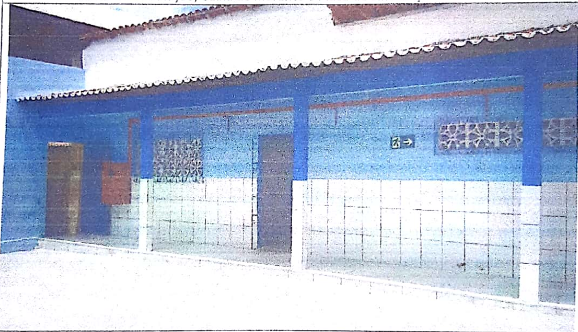
Foto 03: Demonstra Caixa de Hidrante e Placa de Sinalização
