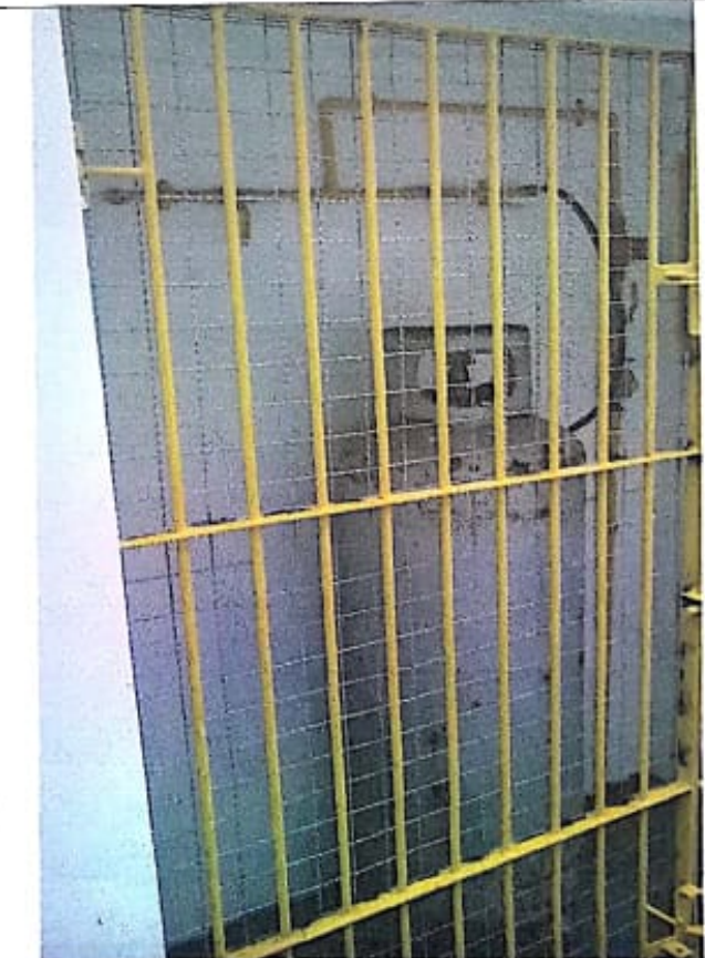
CASA DE GÁS 2 : DETALHE DA COLOCAÇÃO DA TELA DE PROTEÇÃO E EXTINTOR
