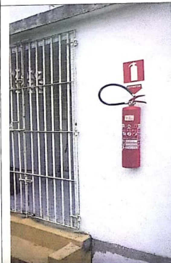
CASA DE GÁS 2 : DETALHE DA COLOCAÇÃO DA TELA DE PROTEÇÃO E EXTINTOR
