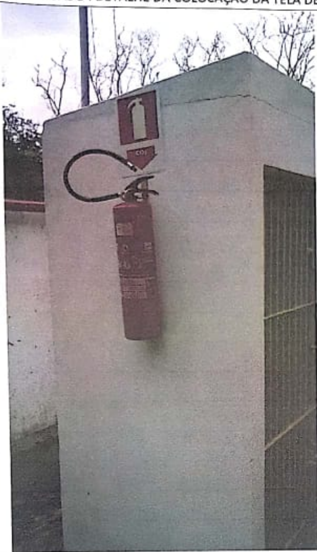
CASA DE GÁS 3 : DETALHE DA COLOCAÇÃO DA TELA DE PROTEÇÃO E EXTINTOR
