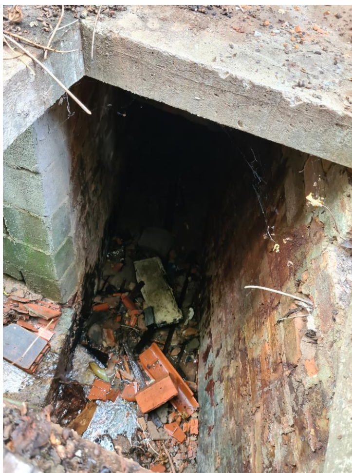
Foto-01_ galeria existente subterrânea.
